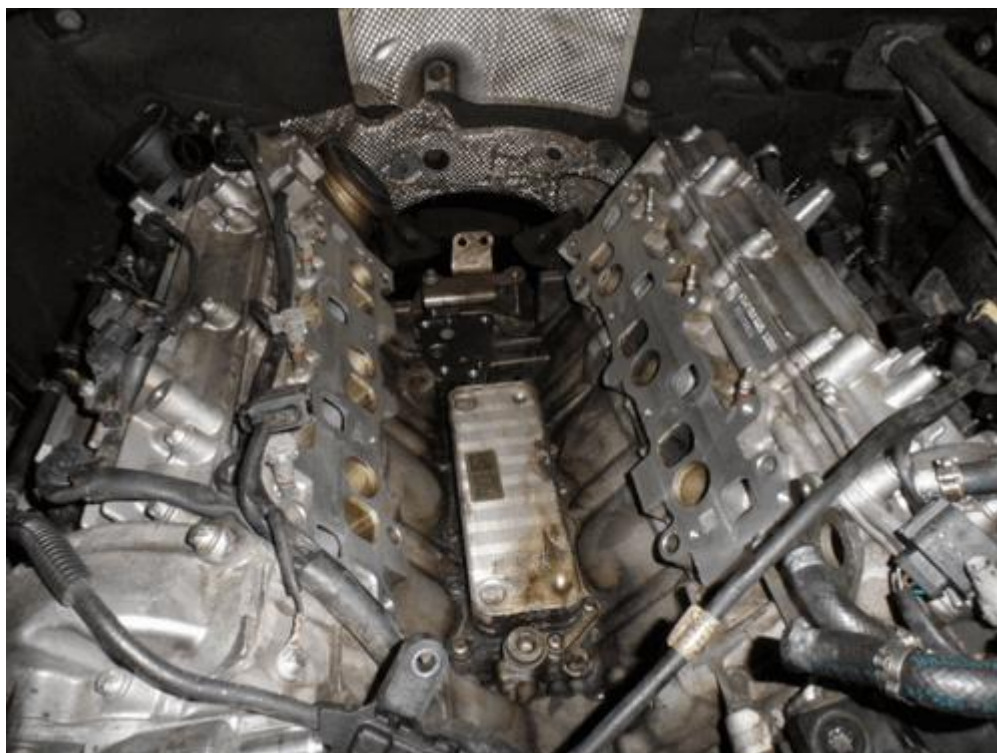
Фото 4 - всё, что нужно – демонтировано
